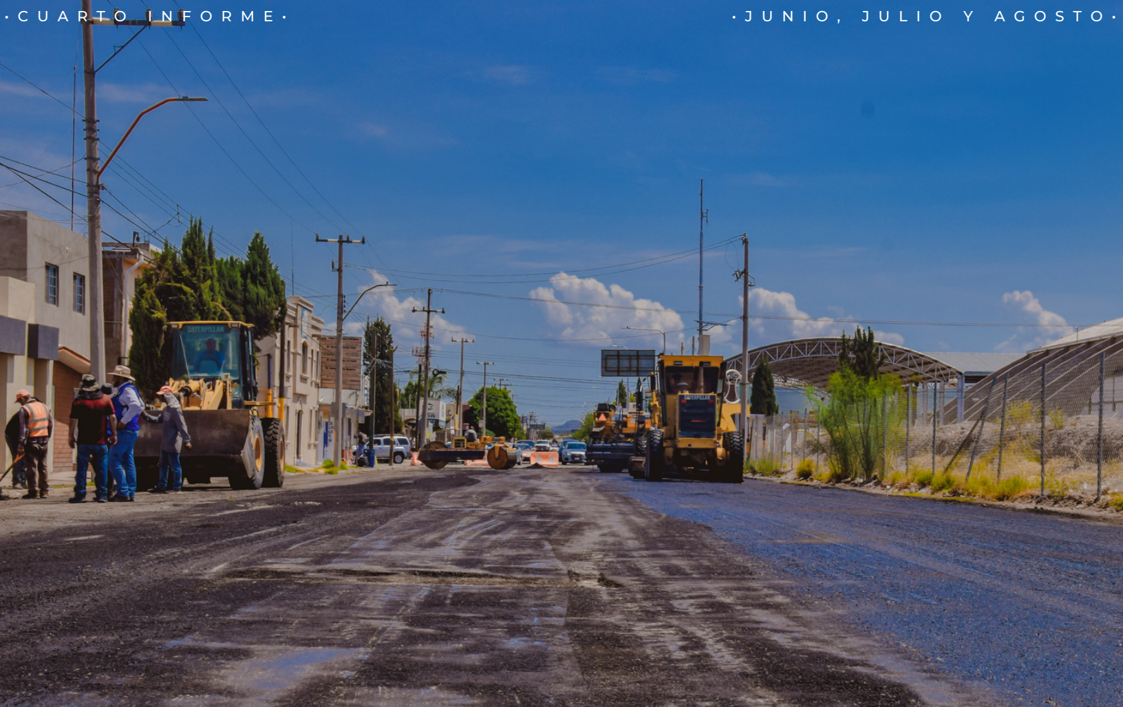
RIEGO DE IMPREGNACIÓN Y RE NIVELADO.
