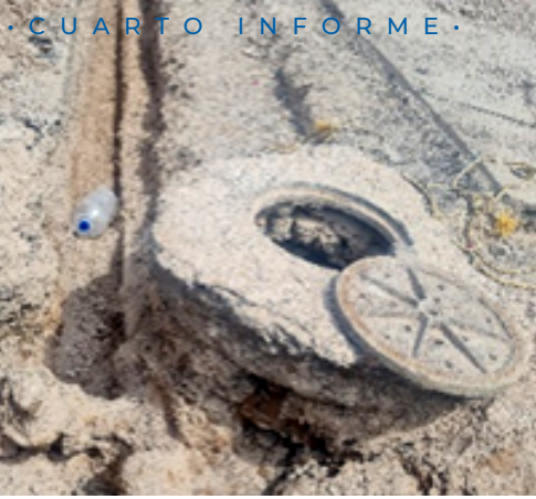
LOS POZOS DE VISITA EN MAL ESTADO FUERON CONSTRUIDOS DE NUEVO.
