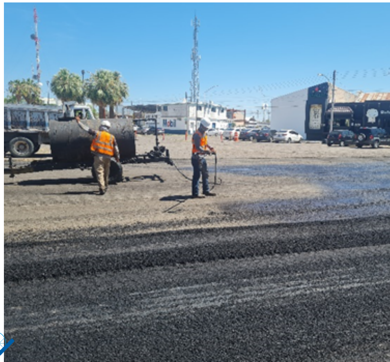
FRESADO POST REEMPLAZO DE TUBERÍAS DE DRENAJE Y AGUA POTABLE
