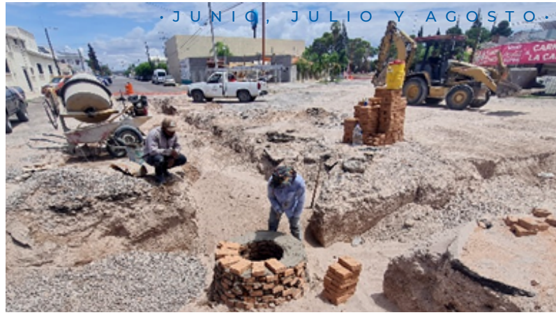
LOS POZOS DE VISITA EN MAL ESTADO FUERON CONSTRUIDOS DE NUEVO.
