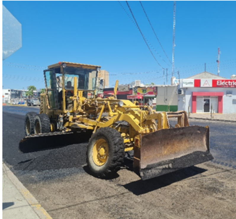
FRESADO POST REEMPLAZO DE TUBERÍAS DE DRENAJE Y AGUA POTABLE
