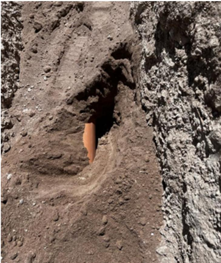
NO SE REALIZÓ LA UNIÓN DE LA TUBERÍA DE DESCARGA DE DRENAJE PREVIO A LA COLOCACIÓN DE LA CAMA DE ARENA, ESTO PROVOCÓ QUE ROCAS, TIERRA Y ARENA SE INTRODUZCA EN LAS DESCARGAS INSTALADAS.
