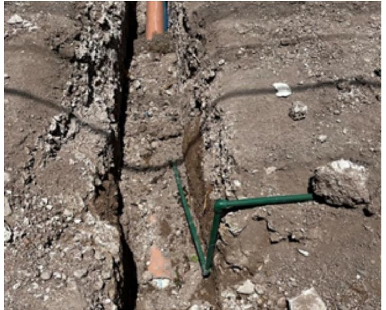
Se observó además que la empresa contratista, no realizó cortes con disco en las banquetas, en las cuales habría de hacer llegar la tubería de descarga de drenaje, causando daño a gran parte de la zona de trabajo, siendo esto innecesario, lo cual propicia que la reposición de esta sea de un costo mayor, el cual no debe ser a cargo del municipio, ya que estas acciones se consideran negligencia por parte de los trabajadores.
