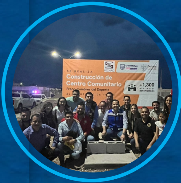
ARRANQUE DE OBRA CENTRO COMUNITARIO CUMBRES DEL DEPORTE
